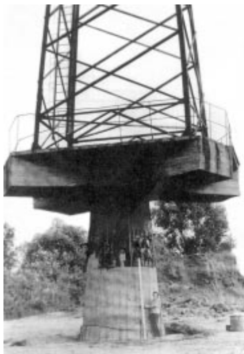
Рис. 1. Опора линии электропередач на правобережной пойме р. Оби, находящаяся в аварийном состоянии из-за размыва берега. Фото В.Н. Дьякова
